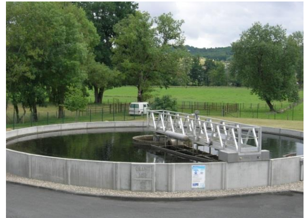
Station d'épuration de Tréllissac
