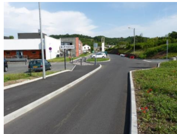
Sécurisation et amélioration de l'accessibilité – Filature de l'Isle – 2017
