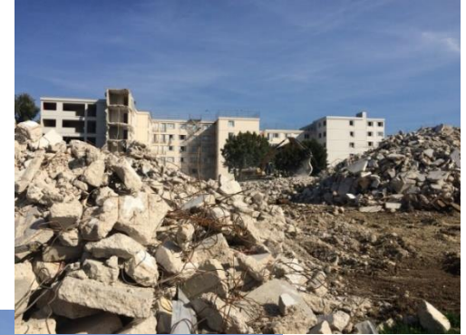
Déconstruction de la Résidence Saltgourde Août 2018
