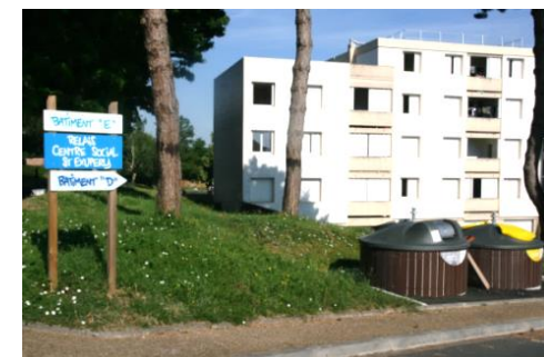
Fabrication de panneaux de signalisation et bornes enterrées – Pagot 2017-2018
