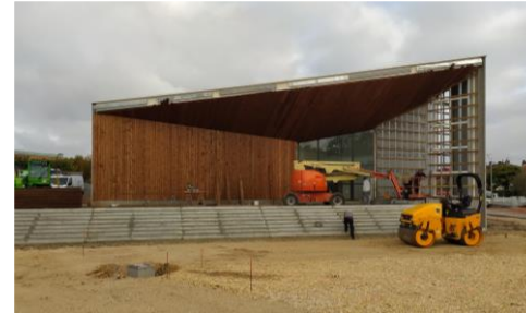
Construction du Pôle des Solidarités – 2021
