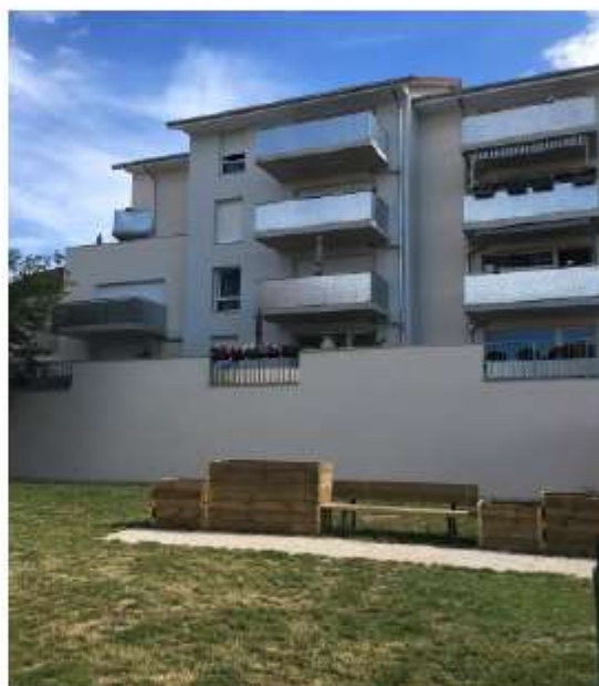
Vue des espaces extérieurs - Photo Cerema
