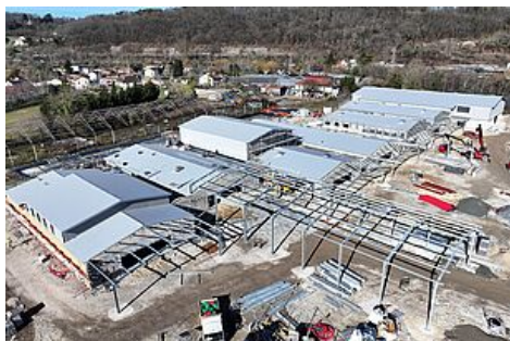
Le Silot est en cours de construction © Grand Périgueux
