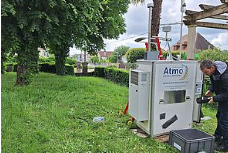
L'installation de la cabine de mesure à Trélissac
