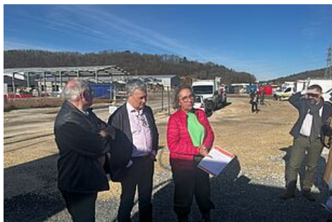
Les élus Thierry Nardou et Thierry Cipierre ainsi que l'architecte Benoîte Doazan assurent que le chantier est dans les temps. © Service communication
