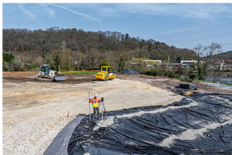
Le démarrage des travaux au Silot © Declic&Decolle
