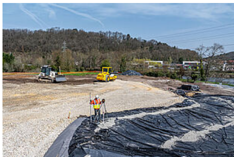
Le démarrage des travaux au Silot © Declic&Decolle
