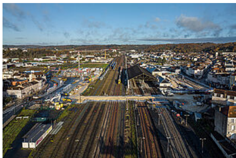
Démolition de la passerelle SNCF, gare de Périgueux - 4 et 5 décembre 2021
