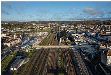
Démolition de la passerelle SNCF, gare de Périgueux - 4 et 5 décembre 2021 © Déclic & Décolle
